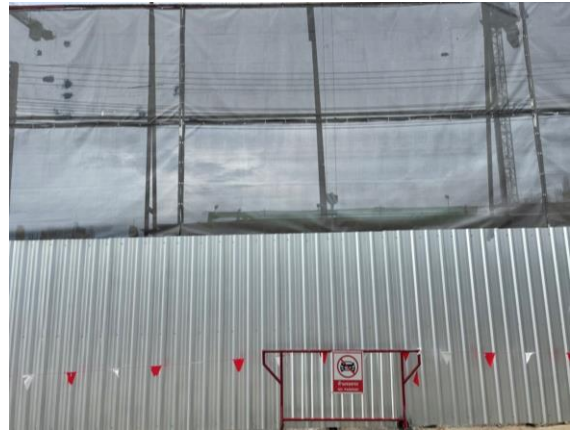
รูปที่ 2 รั้ว Mesh Sheet กันฝุ่น
